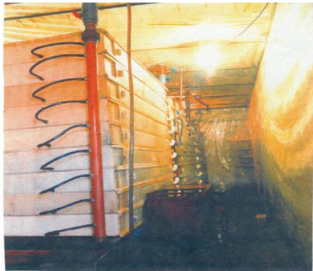
Fig. 2: sistema vertical de boxes o bandejas en una adecuada Instalación (Estación de Ranicultura Don Arturo).
