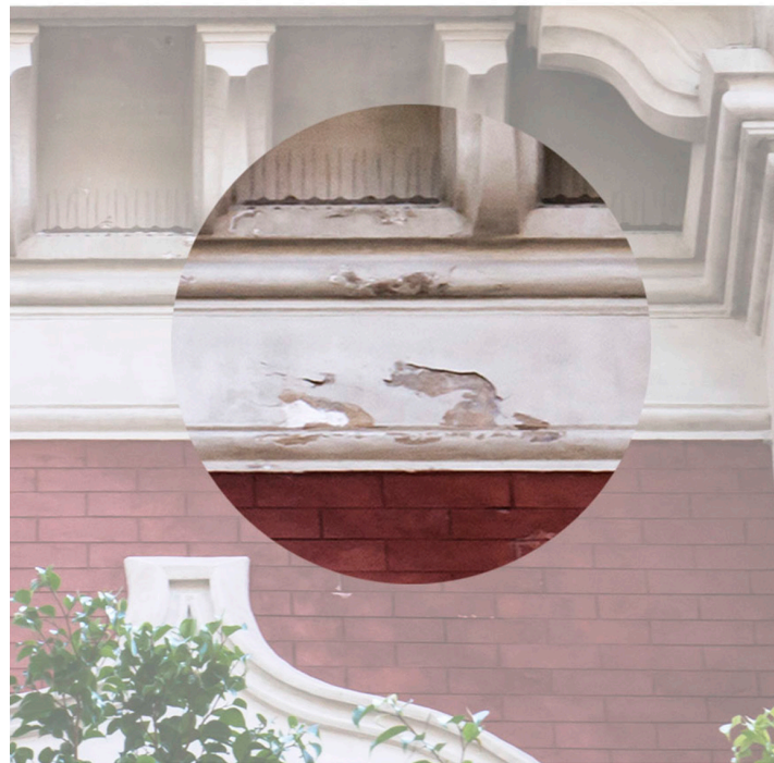
Cara Este del edificio Paseo Colón 982
